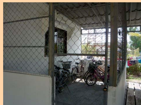
Le nouvel abri à vélos de Koh Kong
